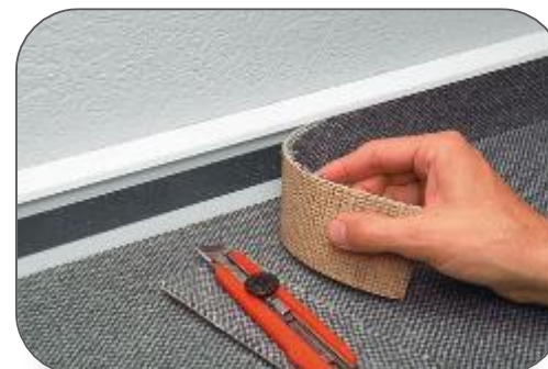
Профиль для полов с ковролинным покрытием
