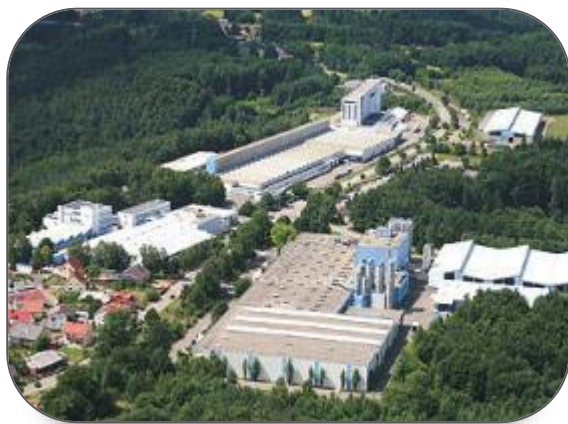
Завод в г. Хельтерсберг (DE)
